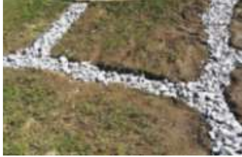
Toprak değişimi ile açık drenaj
